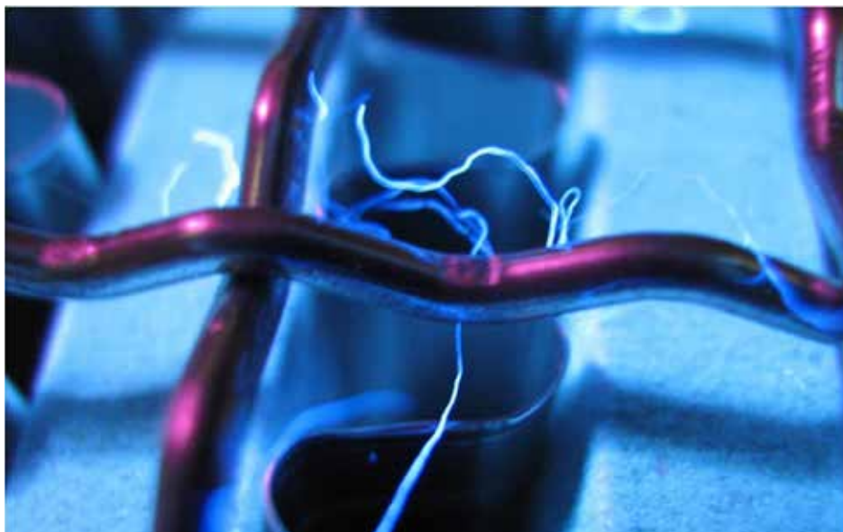
Filtr stropowy strefy nadmuchu widziany w świetle UV ukazujący zagrożenie włókien z poza procesu lakierniczego
