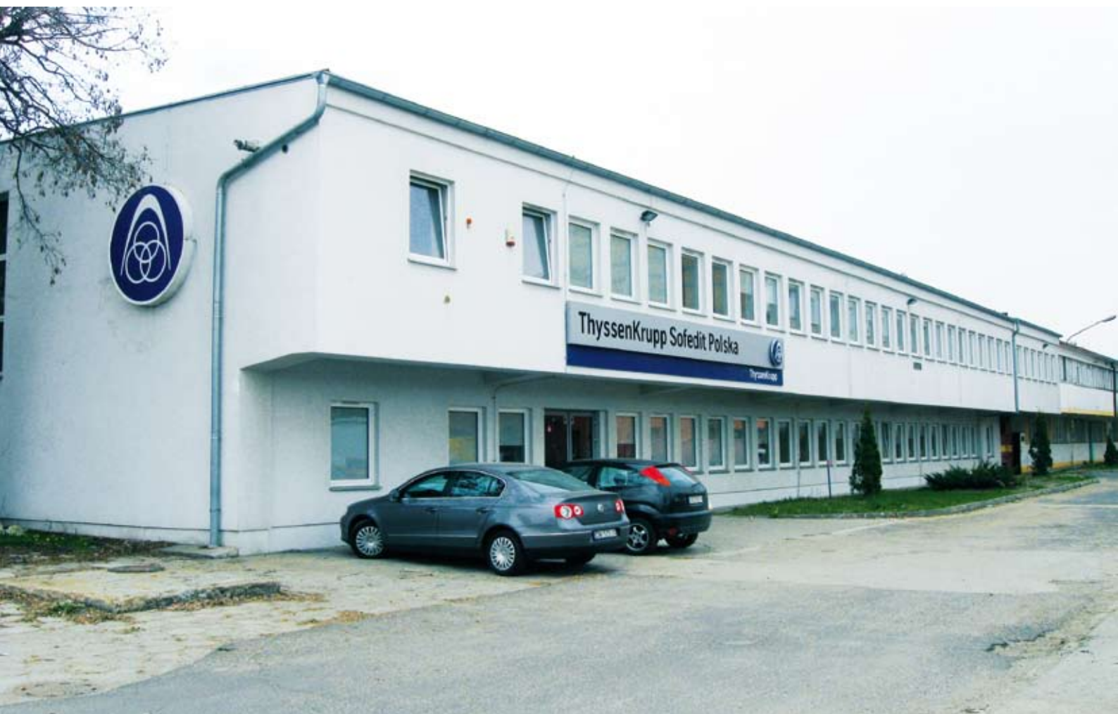
ThyssenKrupp Sofedit Poland
